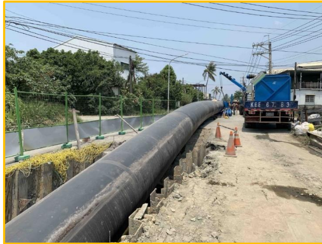
HDPE熱熔接管
