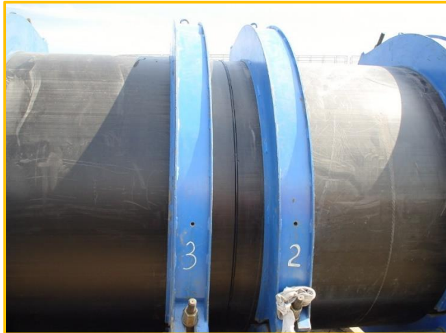
HDPE熱熔施工
