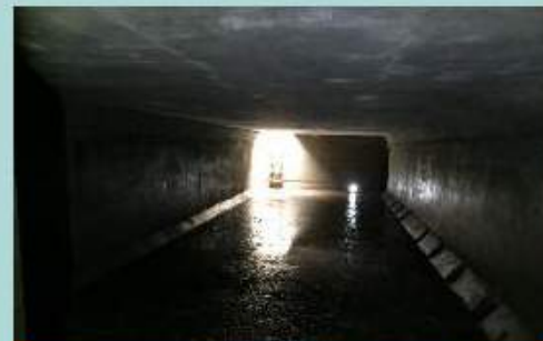
成州國小地下蓄水池
