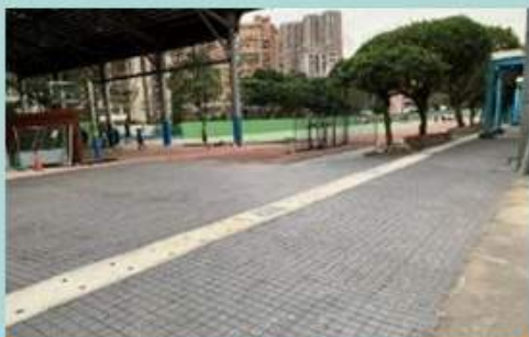
三重高中透水鋪面
