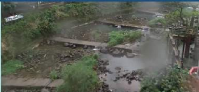
施工前固床工阻擋水流及洄游路徑
