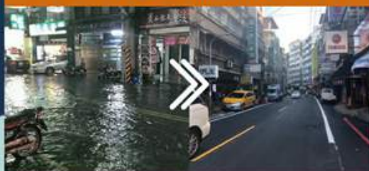
板橋區大仁街瓶頸段積改善
