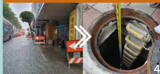
永和區林森路施工管障(FG二期)
