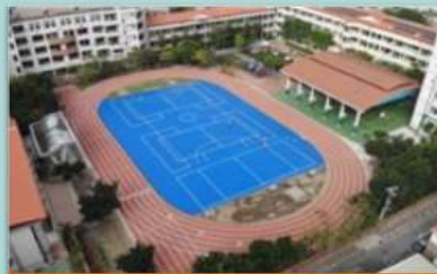
板橋國中操場地下貯留設施
