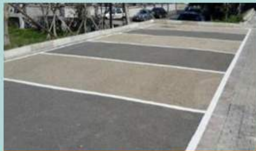
永和營運中心磁石透水鋪面
