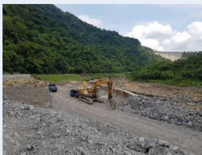
取水口工區圍堰施工
