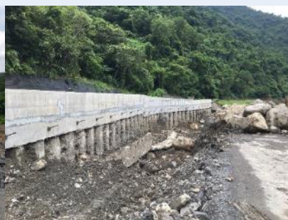
取水口工區圍堰施工
