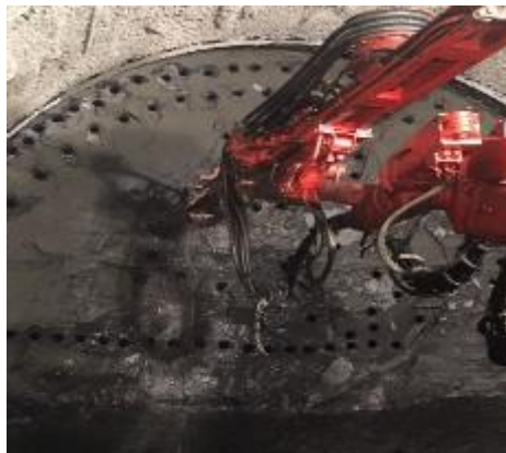
開挖施作預裂孔
