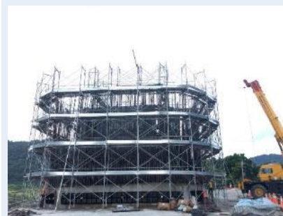
出水口工區沉箱/便道施工
